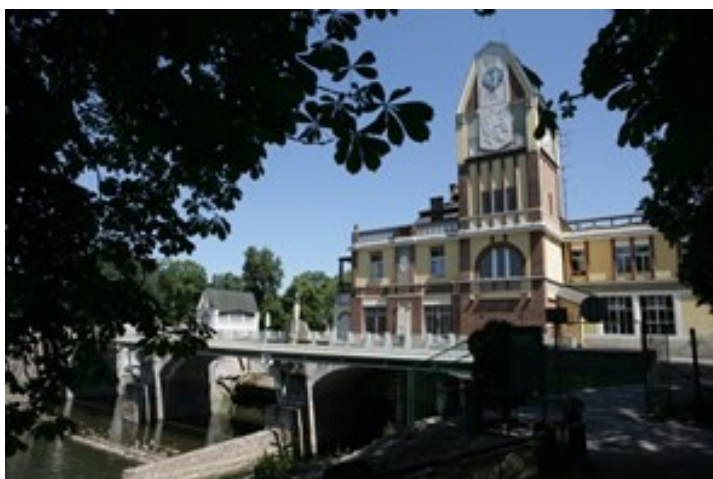
Obrázek č. 1 – Vodní elektrárna Hučák
